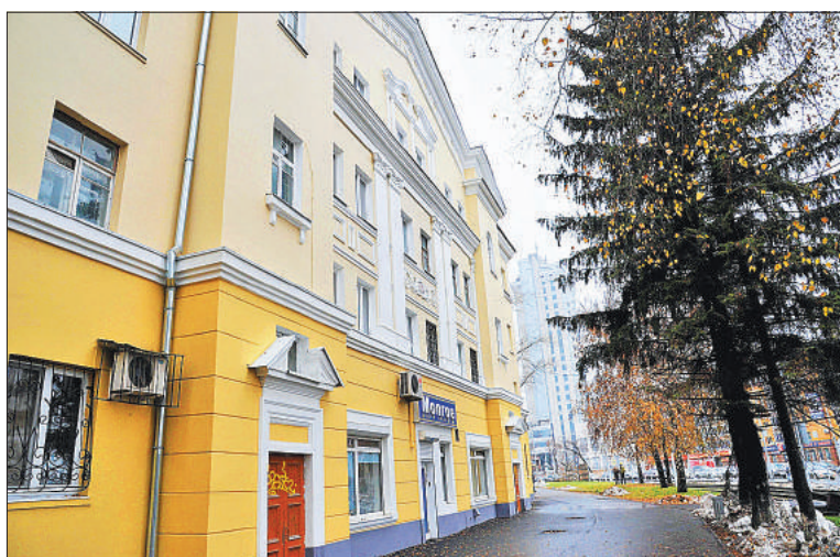
В доме №163 на ул. Ново-Садовой, возведенном в 1940-х годах, капитально отремонтирован фасад. Работы стоимостью 5,5 млн рублей провели в августе и сентябре этого года по областной программе подготовки к ЧМ-2018.
